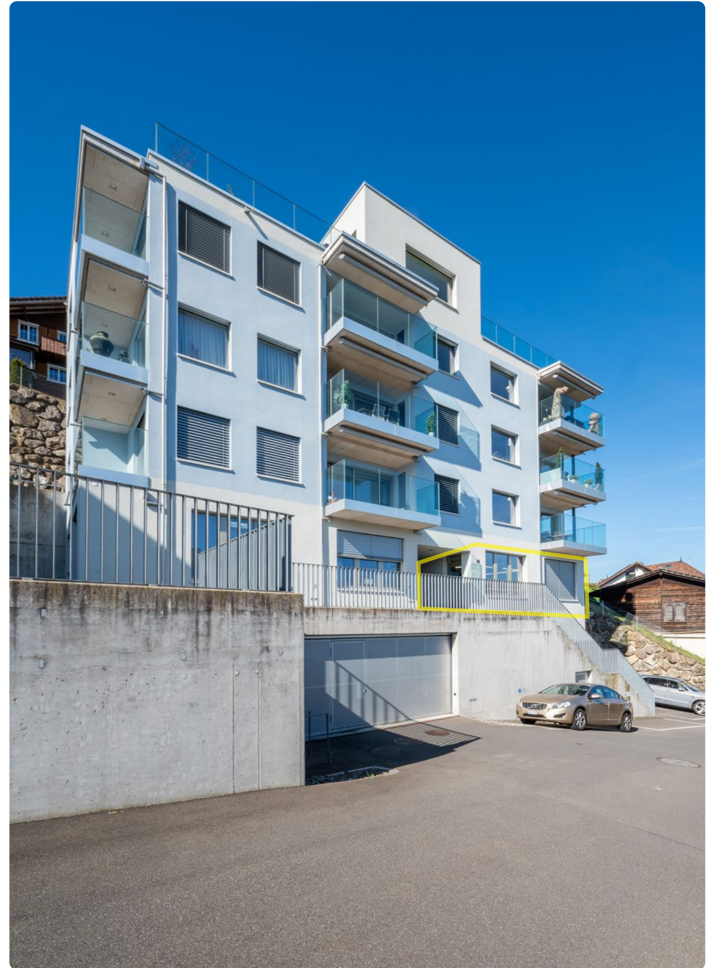
Gebäude P96 West mit dem Büro im EG
